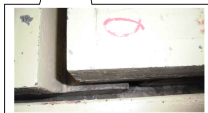
水の流出を考慮する平板間の隙間
