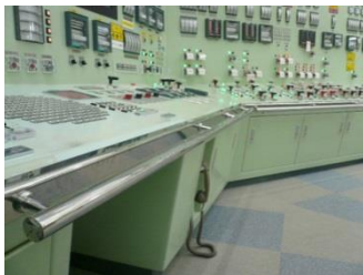
手摺設置状況
