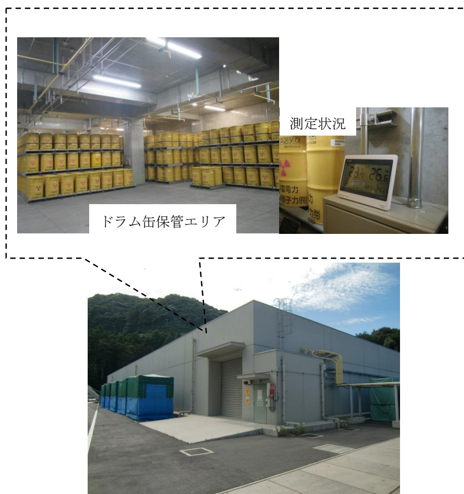
図2 建物内温度の測定状況（固体廃棄物貯蔵所）
