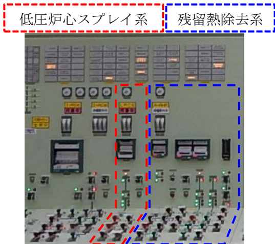
図 2-4 系統区分による配置例
