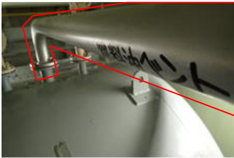
ディーゼル燃料デイタンク周辺敷設状況
