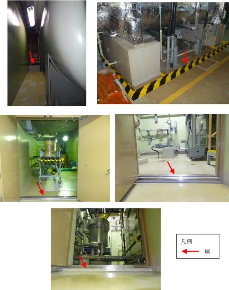
図4-1 漏えい油の拡大の防止対策の例
