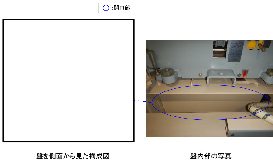
図1 実機の電気盤の開口部 (M/C)
