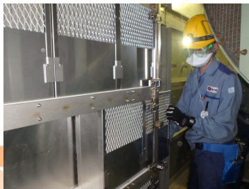
フィルタ抜取作業
