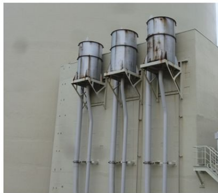
図 3 主蒸気大気放出弁消音器の設置状況 (左 1号炉、右 2号炉 (各 3系統))
