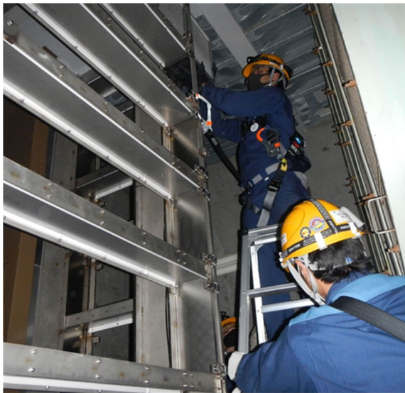
高所のフィルタ取付作業状況
