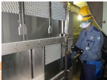
フィルタ抜取作業
