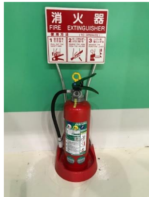
・消火器具 (左から, 粉末 (ABC) 消火器・大型粉末消火器)
