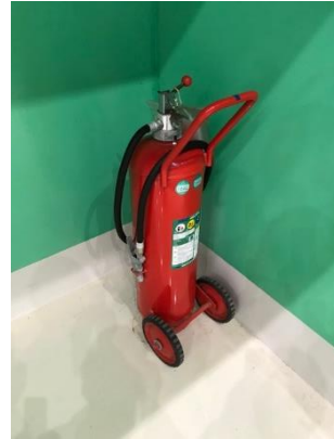
・消火器具 (左から, 粉末 (ABC) 消火器・大型粉末消火器)
