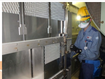
フィルタ抜取作業
