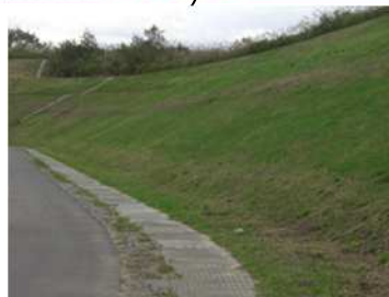
貯蔵建屋南西側法面(芝)
