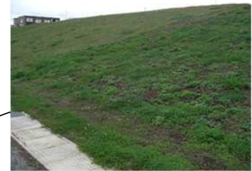
貯蔵建屋東側法面(芝)
