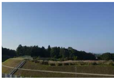
貯蔵建屋北西側(法面上はミズナラ群)
