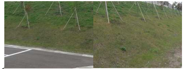
貯蔵建屋北側法面(芝)
