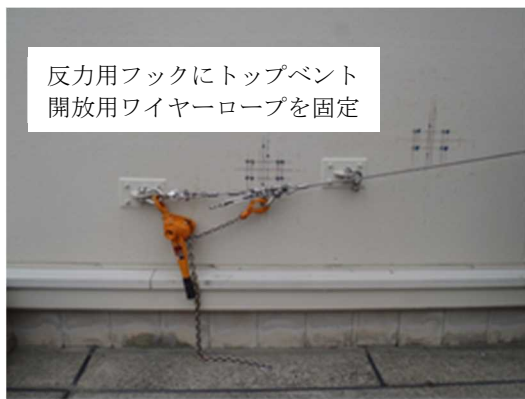
レバーブロックによる原子炉建屋 トップベント開放後の固定
