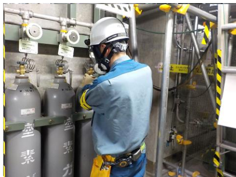
窒素ガスポンベ取替え
