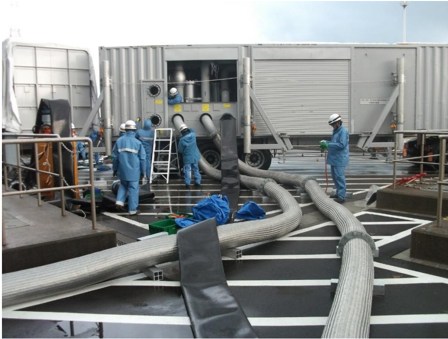
熱交換器ユニット設置作業
