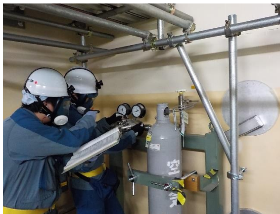
ポンベ取り付け
