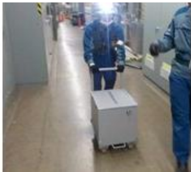
逃がし安全弁用可搬型蓄電池運搬
