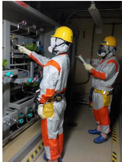
減圧状況の確認（現場）
