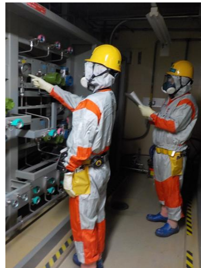
減圧状況の確認（現場）
