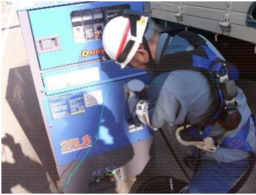
発電機設置状況
