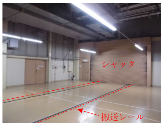
補足図2 室間のシャッタ部及びレール部の実例
