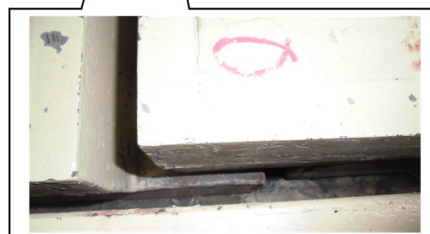
水の流出を考慮する平板間の隙間
