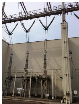
図 1-24 ブッシングの外観及び内部構造部のイメージ図
