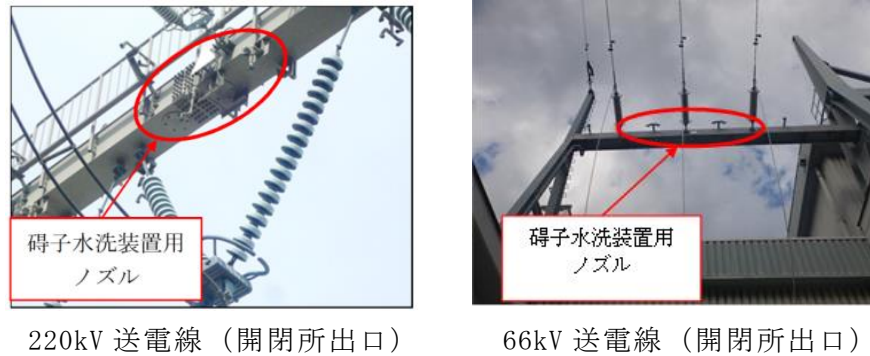
図 3-21 碍子洗浄装置外観
