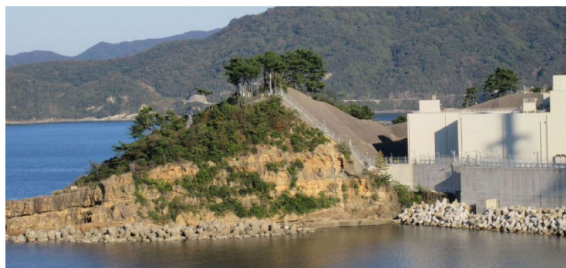
図 1.2-13 防波壁（東端部）地山状況
