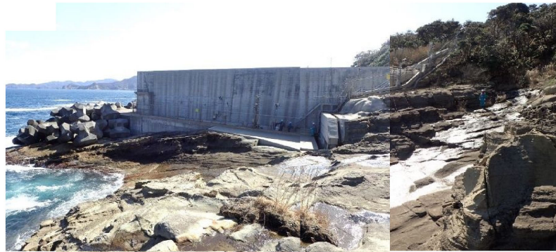
図 1.2-14 防波壁（西端部）地山状況
