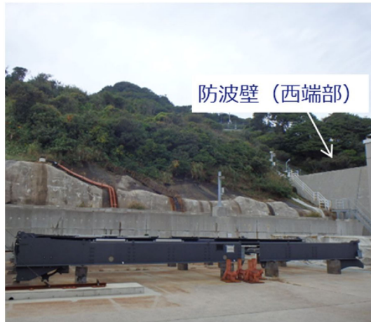
図 1.2-11 防波壁西端部 状況写真
