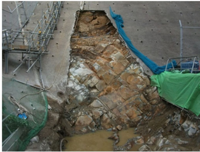
图 1.2-9 防波壁東端部 岩盤露出狀況
