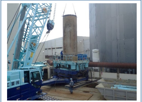
オールケーシング工法の施工例
