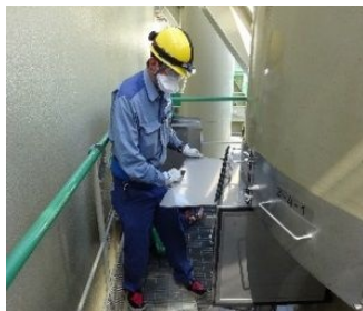
閉止板取付作業
