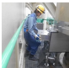
フィルタ抜取作業
