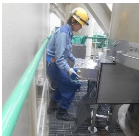
フィルタ抜取作業
