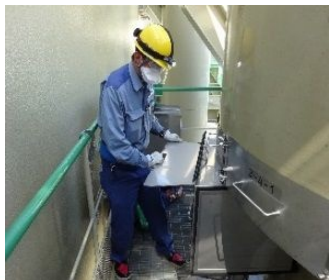
閉止板取付作業
