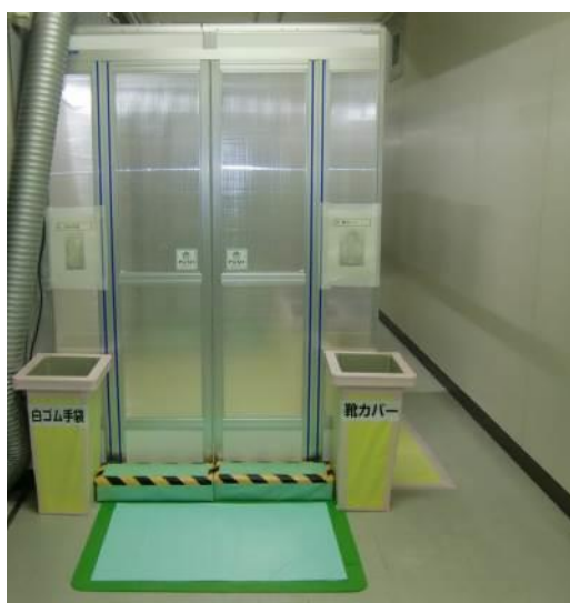
図 1.1-7 チェンジングエリアの外観
