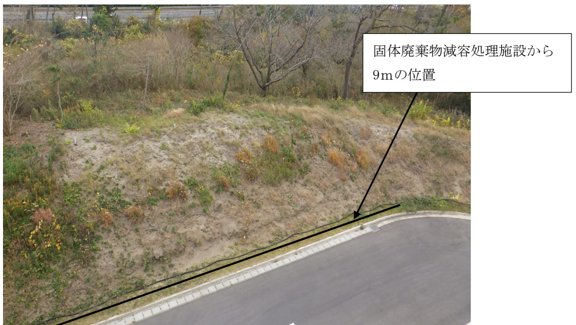
図-2 固体廃棄物減容処理施設東側の樹木の植生状況（東南方向）
