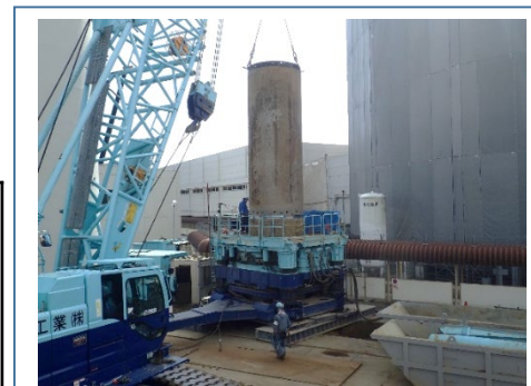
オールケーシング工法の施工例
