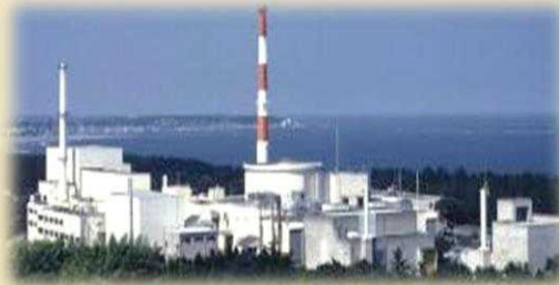
高速実験炉「常陽」
