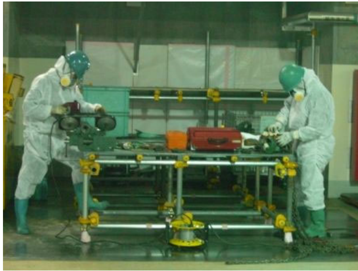
第 27－9 図 切断作業の状況
