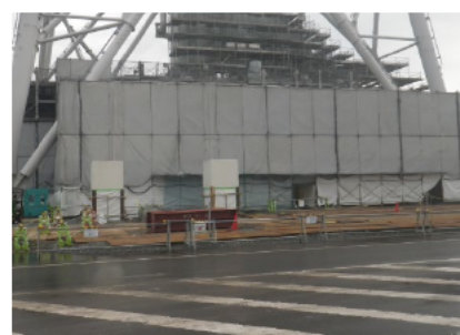
③試薬建屋入口から 北側を撮影
