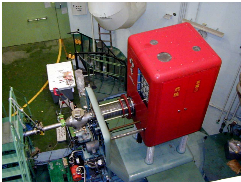
図 B-3 パルス状中性子発生装置 (加速器本体)
