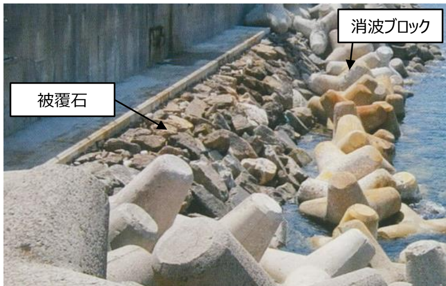
被覆石の設置状況（1，2号機北側護岸）
