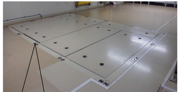
開口部のコンクリート平板による閉止状態
