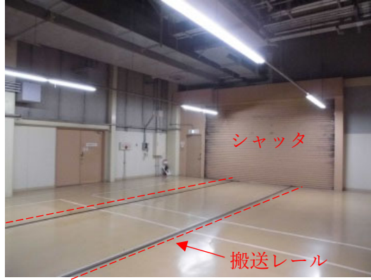
補足図1 室間のシャッタ部及びレール部の実例
