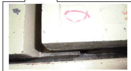
水の流出を考慮する平板間の隙間
