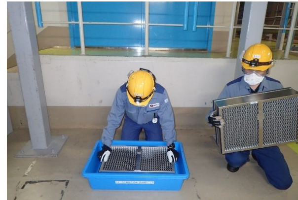
フィルタ清掃作業
