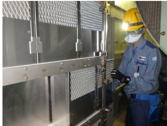
フィルタ抜取作業
