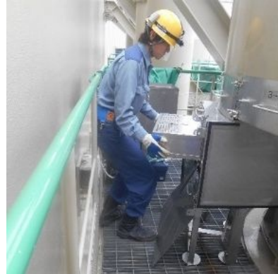
フィルタ抜取作業
