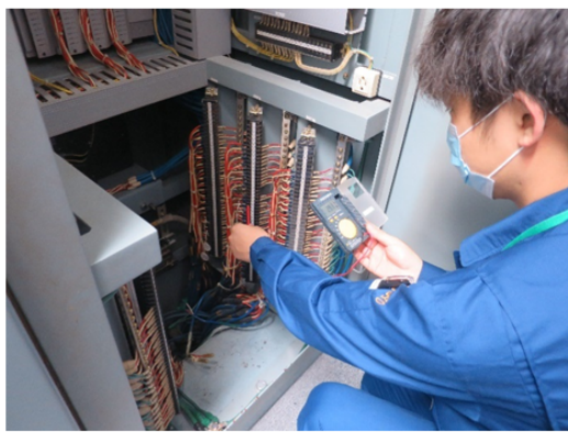
仮設計器による温度確認の一例
