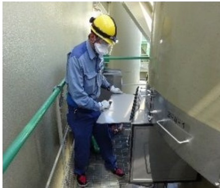
閉止板取付作業
