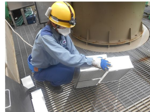
フィルタ清掃作業
