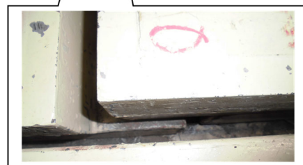
水の流出を考慮する平板間の隙間
