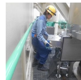
フィルタ抜取作業
