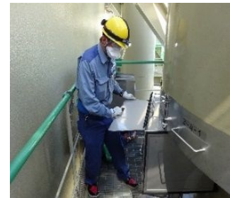
閉止板取付作業
