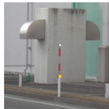
洞道の排気口
