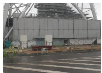
③試薬建屋入口から北側を撮影
