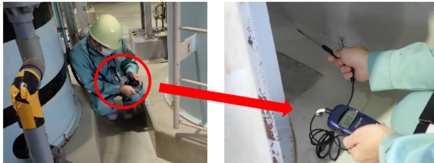
第4図 タンク周りの風速及び温度の測定状況 (第2一般排水処理建屋)
