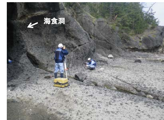
測量写真(福浦港付近)
