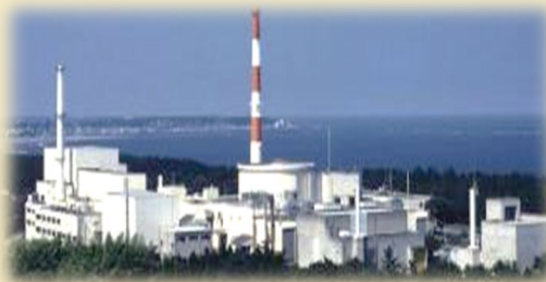
高速実験炉「常陽」
