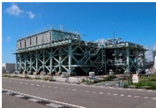
図3-1. 安全冷却水冷却塔のイメージ
