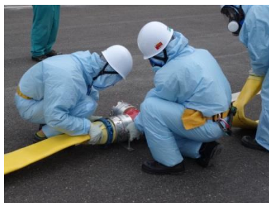
ホース接続作業（昼間）
