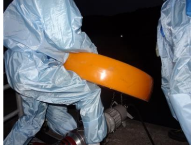
水中ポンプ設置準備（夜間）
