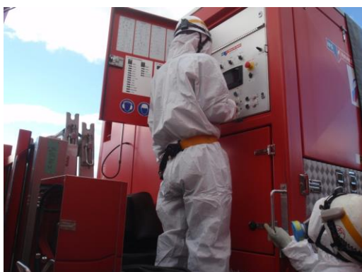
ポンプ起動操作
