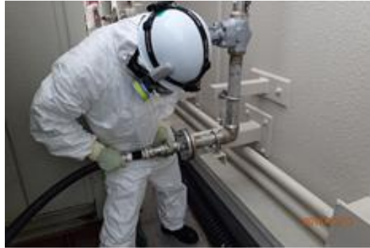
ホース接続作業
