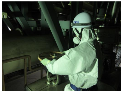
冷却水確保（系統構成）
