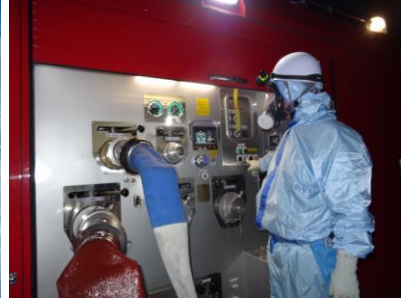
ポンプ起動操作（夜間）
