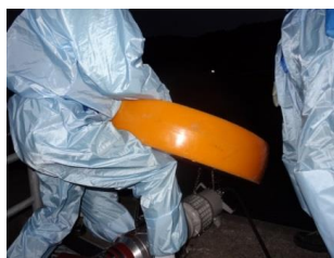
水中ポンプ設置準備（夜間）
