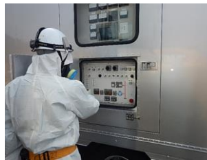
高圧発電機車での作業
