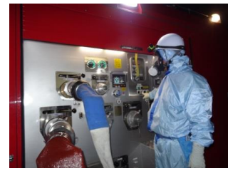
ポンプ起動操作(夜間)
