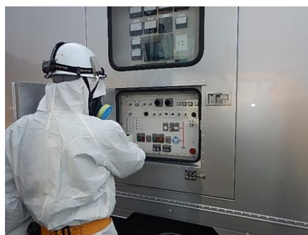
高圧発電機車での作業
