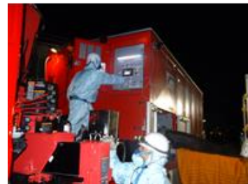
ポンプ起動操作（夜間）
