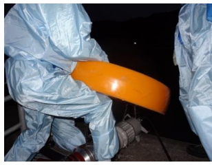
水中ポンプ設置準備(夜間)
