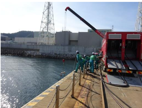
水中ポンプ設置の状況
