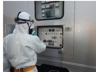
高圧発電機車での作業
