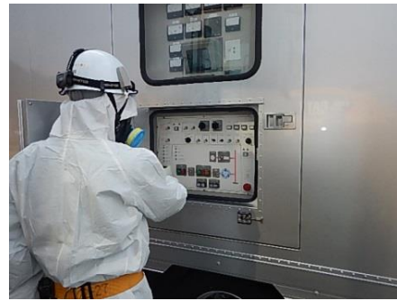
高圧発電機車での作業
