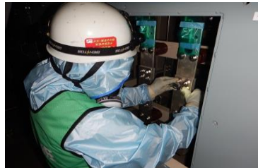
ボルトリンク接続作業
