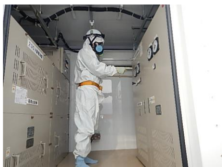
直流給電車での作業
