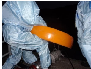
水中ポンプ設置準備（夜間）
