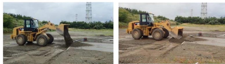
段差復旧状況①
