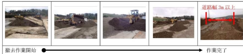
第10図 土砂撤去状況写真
