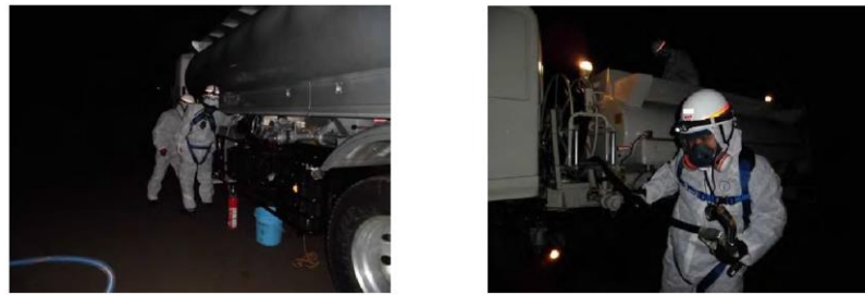
第3図 放射線防護具類を着用した状態での作業状況
