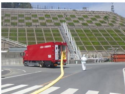
ホース敷設作業 (E L 8.5m~15m 西側道路付近)
