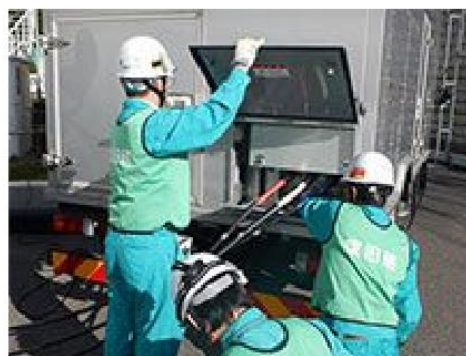
高圧発電機車を用いた電源供給訓練の状況 （写真は全交流動力電源喪失時を想定した電源ケーブル接続作業）
