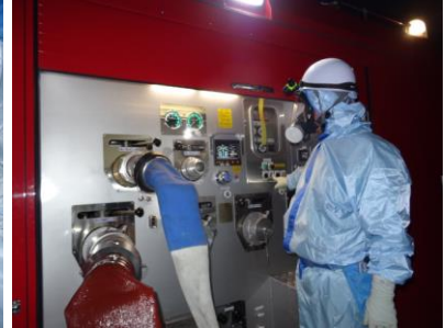
ポンプ起動操作（夜間）
