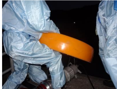
水中ポンプ設置準備（夜間）
