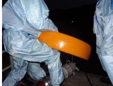
水中ポンプ設置準備（夜間）
