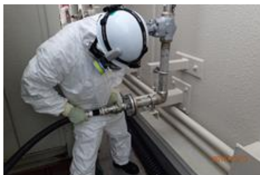
ホース接続作業
