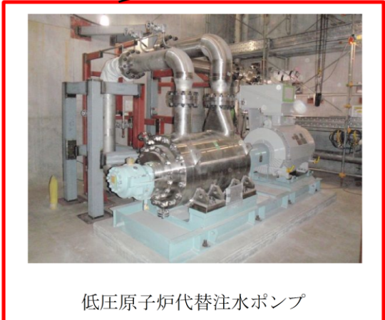
図2 低圧原子炉代替注水系(常設)による原子炉注水に係る機器(低圧原子炉代替注水ポンプ)の配置図
