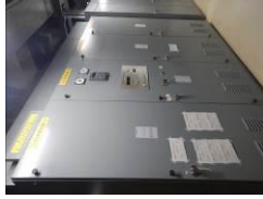
A-115V系直流盤 外観
