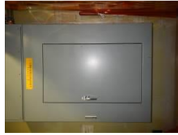
A-原子炉中性子計装用 分電盤 外観
