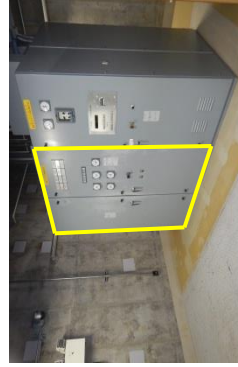
高圧炉心スプレイレイ系充電器 外観
