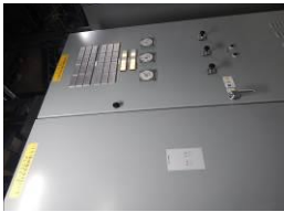
A-原子炉中性子計装用 充電器 外観
