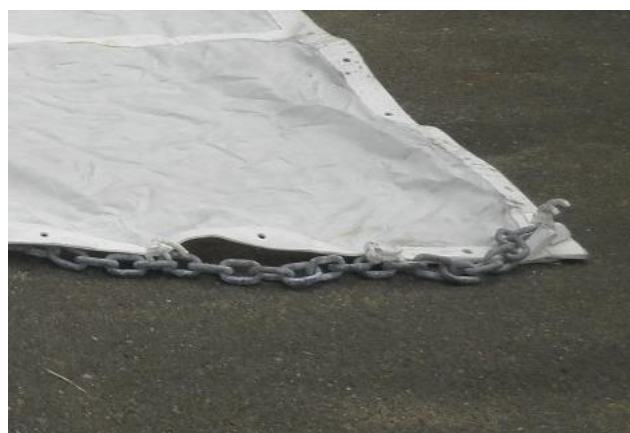
端部拡大写真（重り（チェーン））
