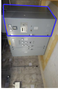
高圧炉心スプレイレイ系直流流盤 外観
