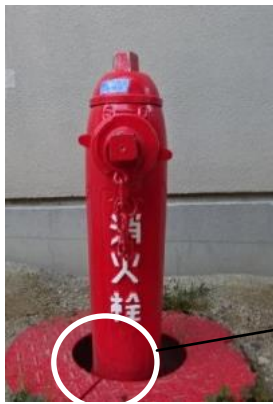
第 41-1-28 図 屋外消火配管への保温材設置状況
