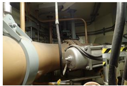
NGC N2ドライウエル 出口隔離弁 (第1弁 (D/W側)) (MV 217-4)
