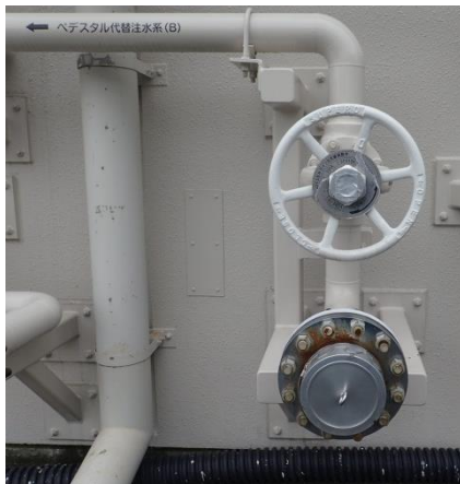
A P F S B-注水ライン流量 調整弁 (V2B6-1B)
