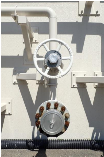
ACSS B-注水ライン 流量調整弁 (V2B5-1B)
